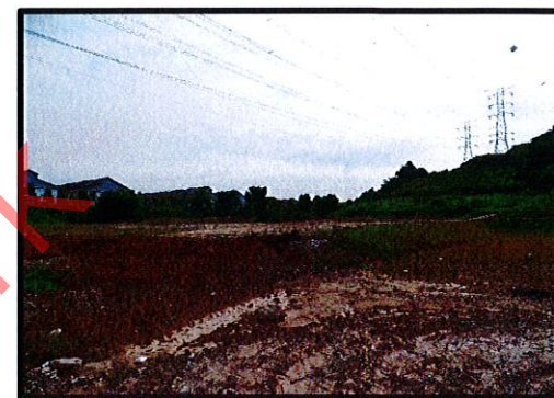
TIMUR : TAPAK DALAM PERANCANGAN PEMBANGUNAN, SEDANG DILAKUKAN KERJA KERJA TANAH
